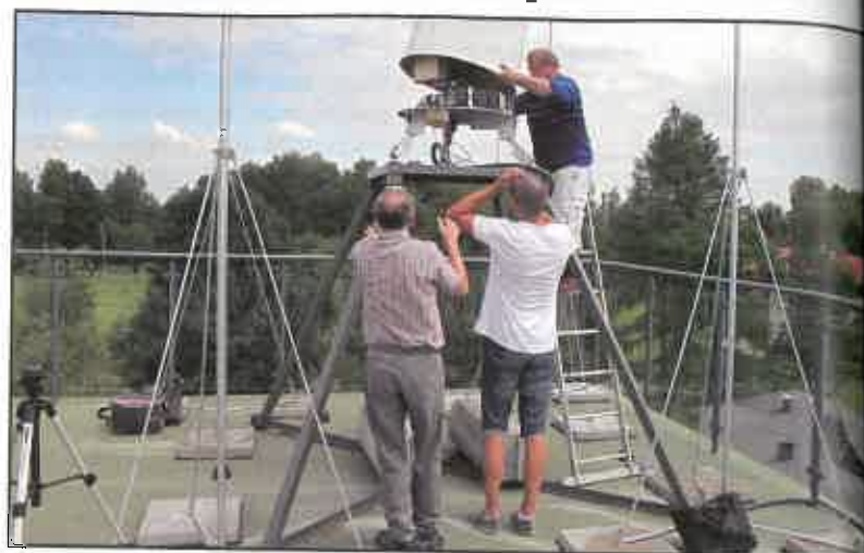
Montaż radaru pasma X w Goczałkowicach
